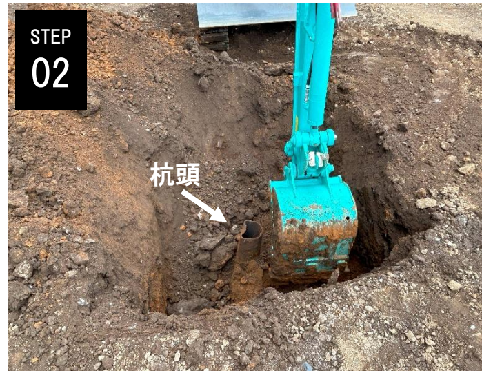
2. 杭頭周辺の掘削及び杭頭部確認
