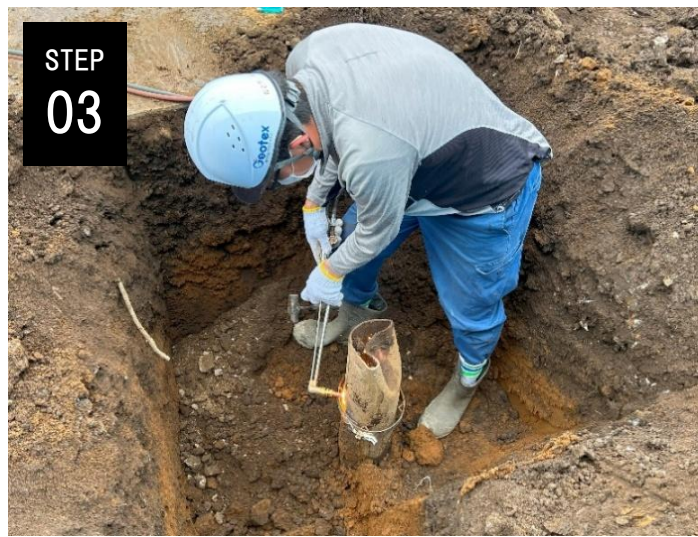
3. 基礎撤去掘削により変形した杭頭部の切断
