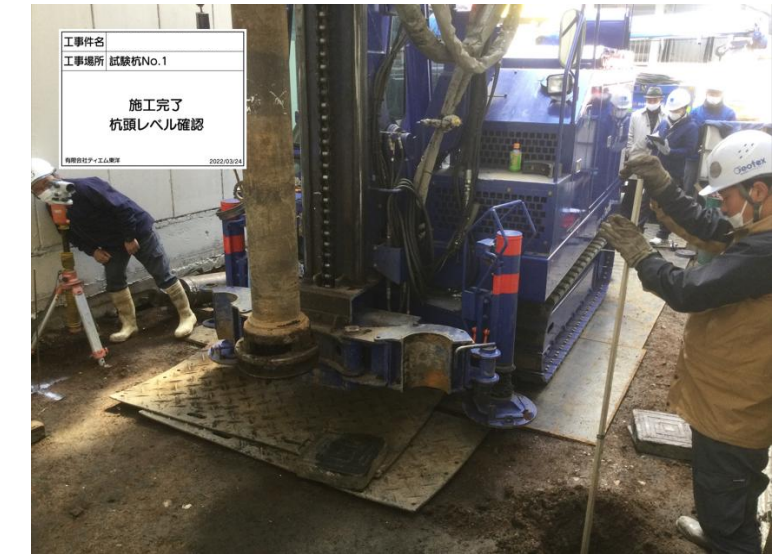
施工状況 ※前面道路にて杭打機方向転換
