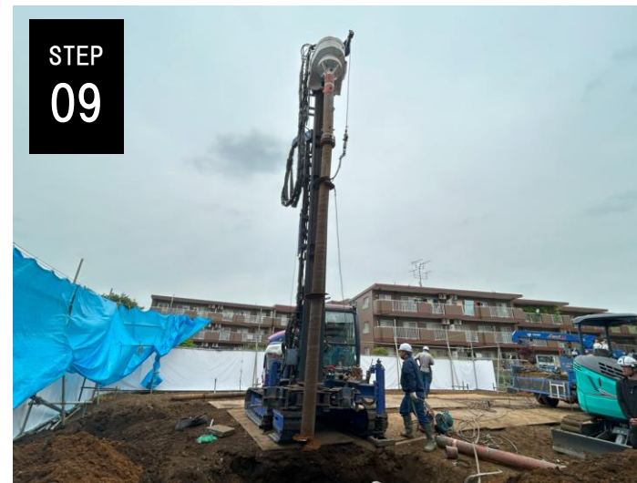
9. 下杭の引抜き
