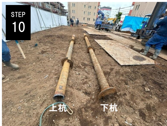
10. 引抜き回収完了
