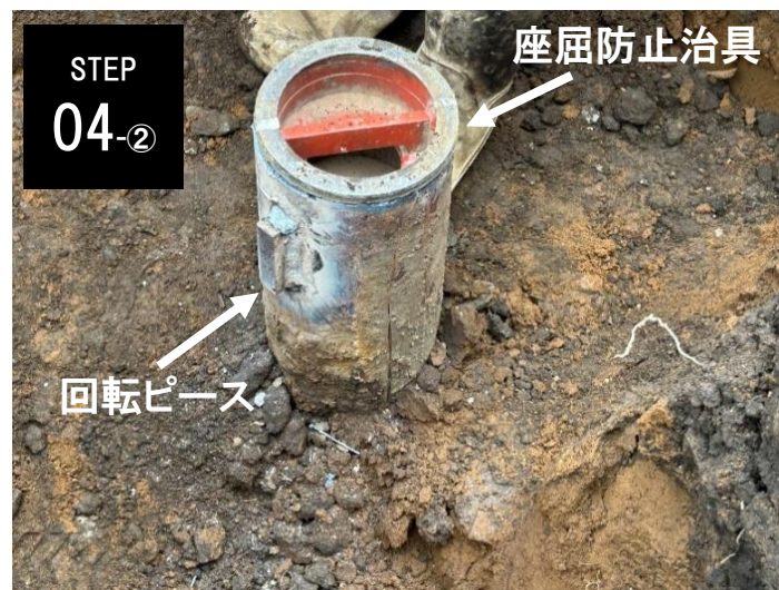
4-②. 回転ピース取付・座屈防止治具設置
